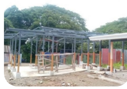
Construcción obra nueva
