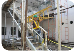
Mantenimiento o correctivo
